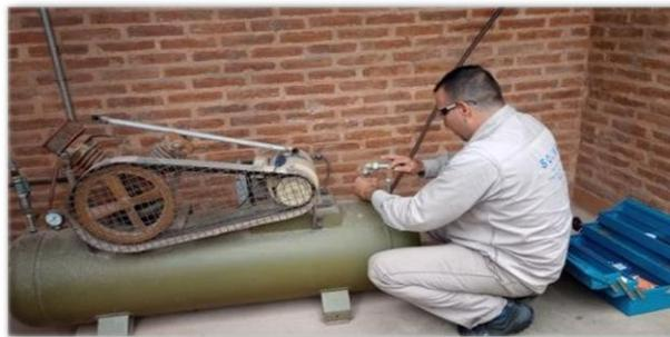
*Vista de controles en compresor de aire utilizado en la operación del horno pirolítico.*
